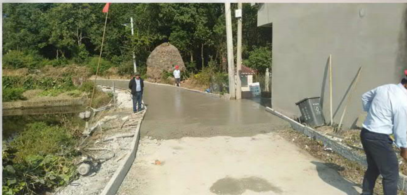
高士镇通组道路修葺
