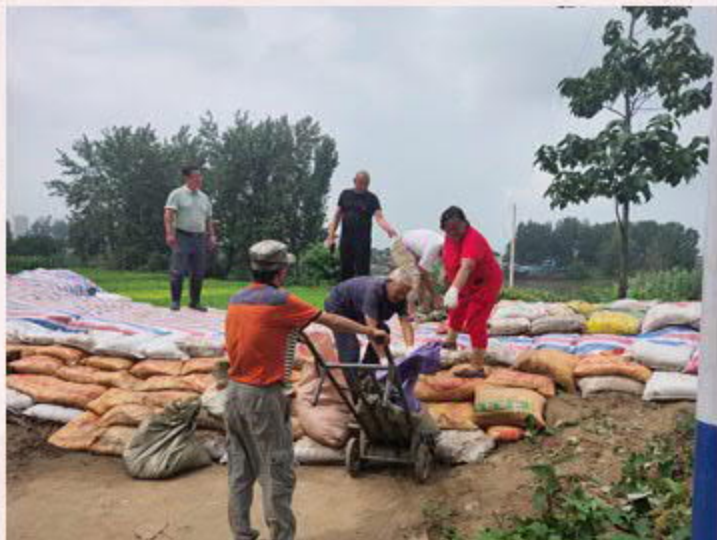
防汛加固堤坝
